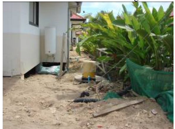
Filling up the level behind Villa D1, D2, D3
