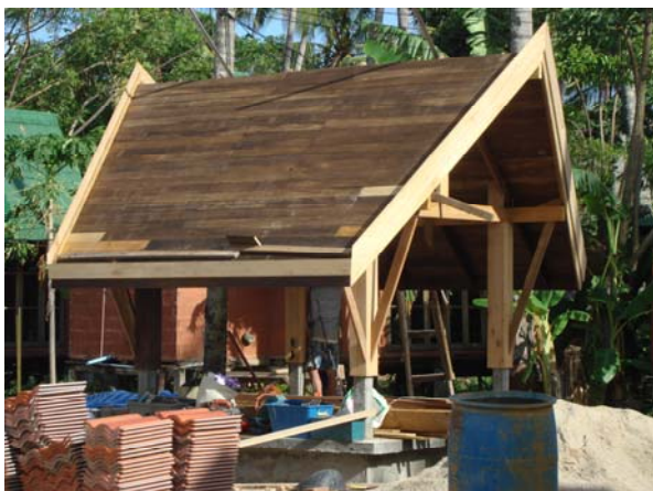
Sala work at F1
