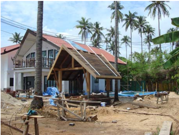
Sala work at villa F1
