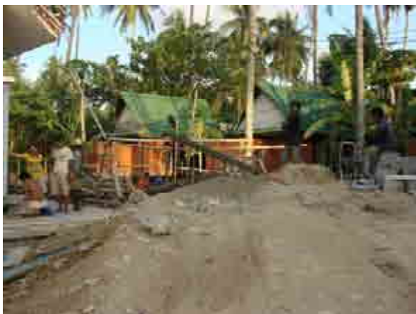
Concret work at pool F1
