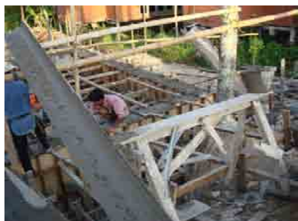
Concret work at pool F1
